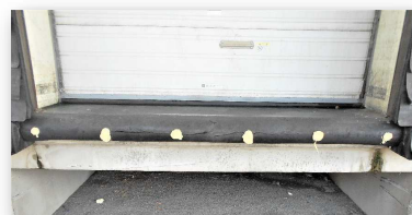
暫定的にバンパー内に硬化剤を入れた外観
